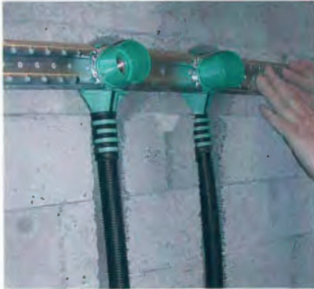
Figur 5.5: Veggbokser med tilbehør plasseres i riktig høyde
