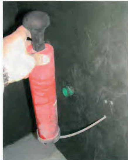
Figur 5.12: Hullet blåses rent for støv før tokomponent masse presses inn i forberede hull
