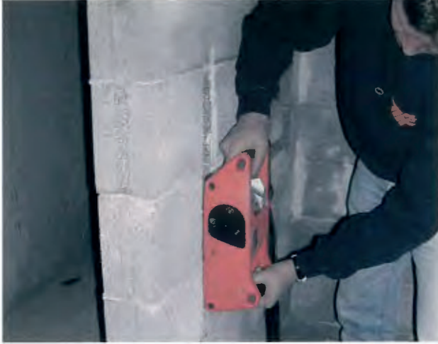
Figur 5.1: Slissing av spor for rør
