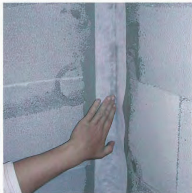
Figur 3.7: Forsterkning av hjørner med tettebånd.
