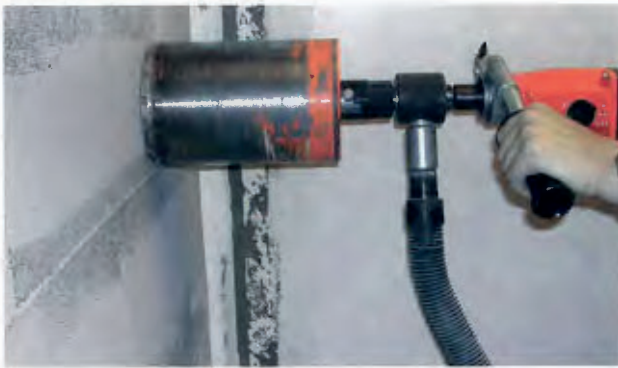
Figur 5.2: Boring av hull for veggbokse
