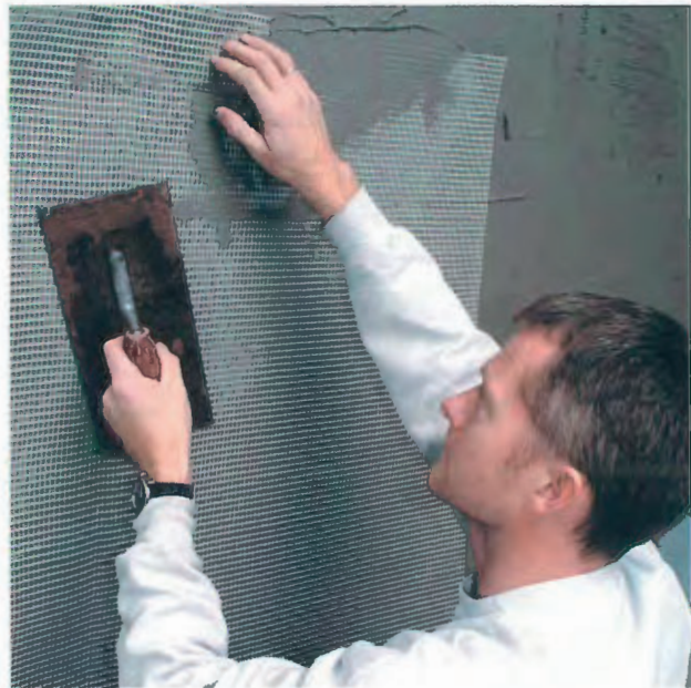
Figur 3.6: Innbaking av alkaliresistent glassfibernet i påstryknings- membran
