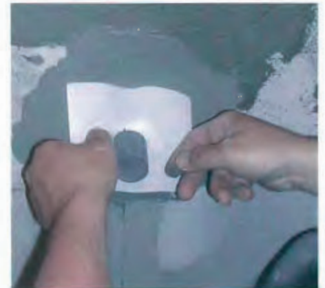
Figur 5.8: Bruk av rørmansjett
