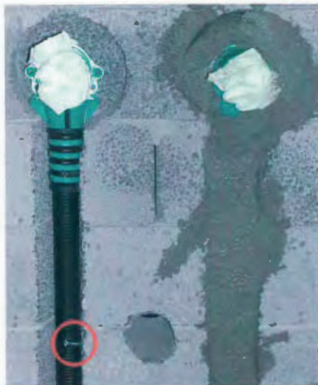
Figur 5.6: I de slissede sporene holdes rørene på plass ved hjelp av spesielle klammere, eller skråspikring. (se rød sirkel)
