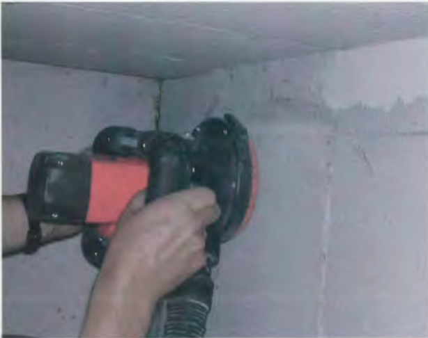
Figur 3.5: Ujevnheter i blokkmurverket fjernes enkelt med egnet slipeutstyr
