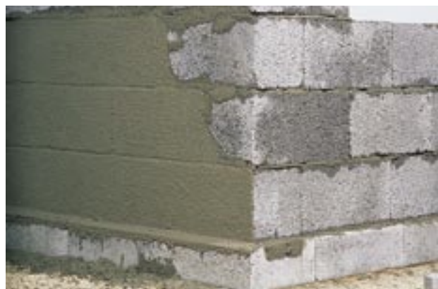
Fig. 3.2.1 Slemming av kjellervegg av lettklinkerblokker. [BMC AS]
