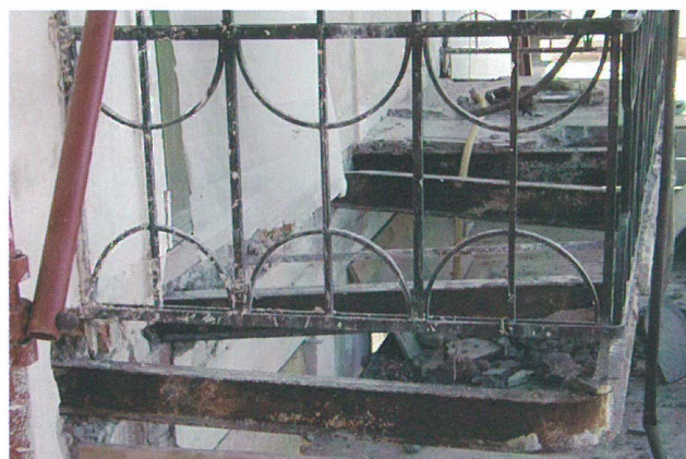
Typisk bæresystem på eldre balkong
