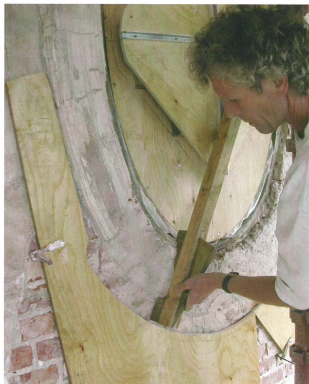
Terje Berner, T. Berner & Co AS utfører trekningsarbeidet.
