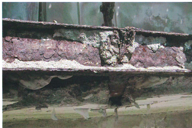
Korroderert stålprofil
