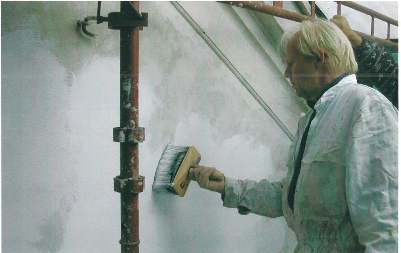
Magnus Freberg, STS-Surface Treatment Systems AS påfører silikat-grunning med gradert fyllstoff
