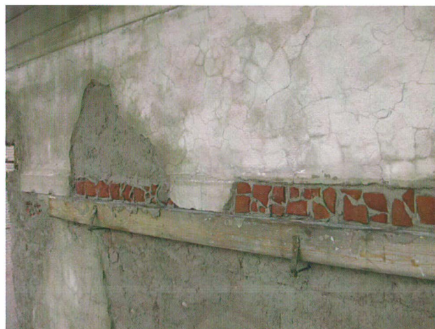
Innmuring av teglbiter.
