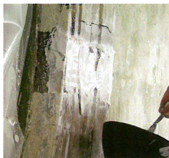
Påføring av gips
