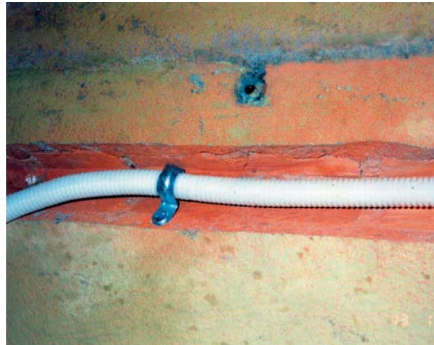
Bilde 6.4.8 Innslissing av trekkerør i gammel puss under isolasjonen
