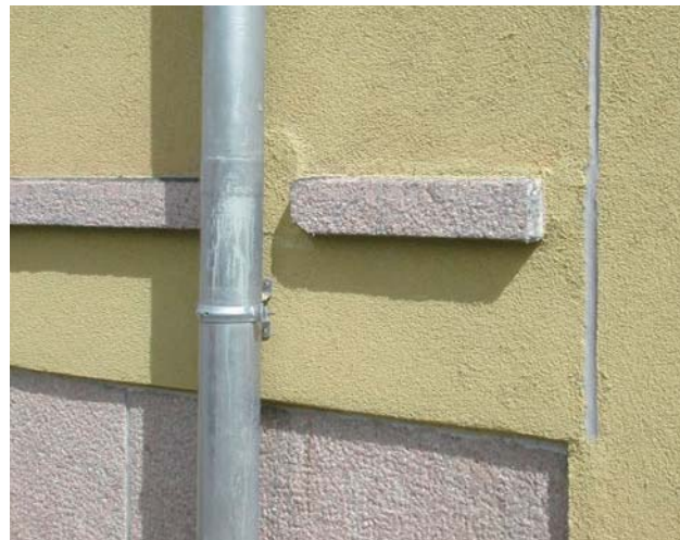
Bilde 6.4.10 Bevegelsesfuger hvor dette er påkrevet
