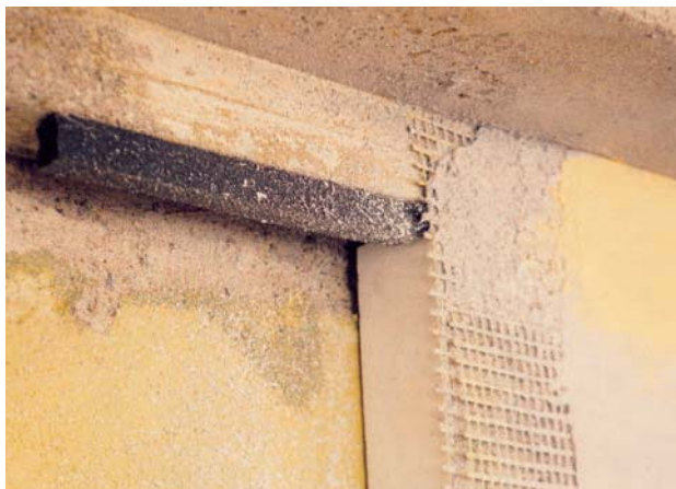
Bilde 6.4.4 a) Bilde 6.4.4 a)-b) Tettelister i materialoverganger
