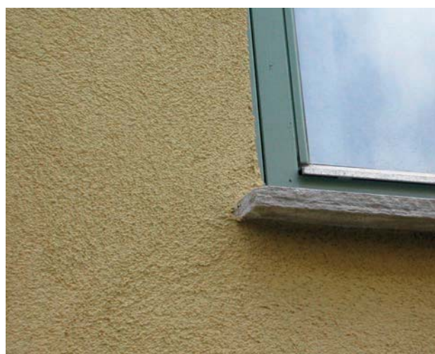
Bilde 6.4.14 c) Bilde 6.4.14 a)-c) Alternative sålebenkavslutninger
