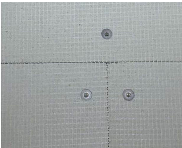
Bilde 6.4.19 Platemontasje med tilpassede skruer i nødvendig avstand fra platekanter
