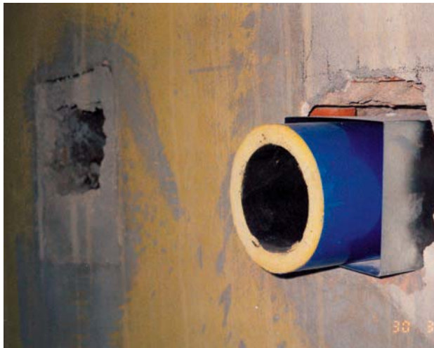
Bilde 6.4.3 a) Bilde 6.4.3 a)-b) Innsetting og innpussing av ny tilluftsventil
