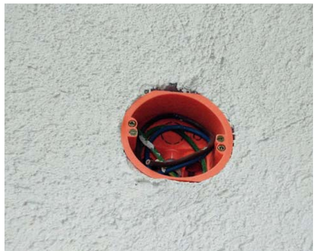
Bilde 6.4.20 Innfelling av lyspunkt krever koordinert detaljprosjektering
