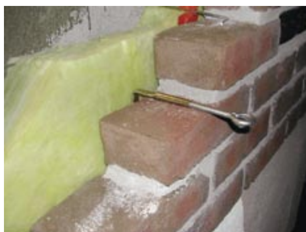
Figur 4.9.1 Eksempel på stillasfeste som legges i mørtelfugen ved oppmuring. Etter at stillaset er fjernet skrues øyebolten ut og hullet tettes med mørtel.
