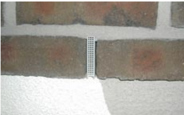
Figur 7.5.2 Stussfugegitter i plast, leveres i grå eller hvit farge.
