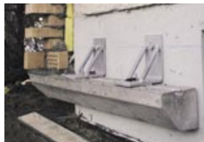
Figur 5.2.1 Prefabrickert betongkonsoll, RI Bæresystem
