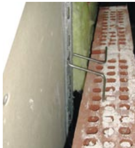
Figur 4.5.1 NP-skinne for ettermontering
