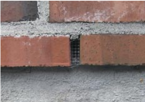
Figur 7.5.1 BI Stussfugegitter er et finmasket nett som er tilpasset stussfugen.
