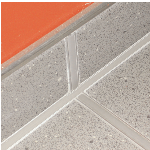
Figur 7.1.1: Randfuger av fugeprofiler langs gjennomgående veggkonstruksjoner
