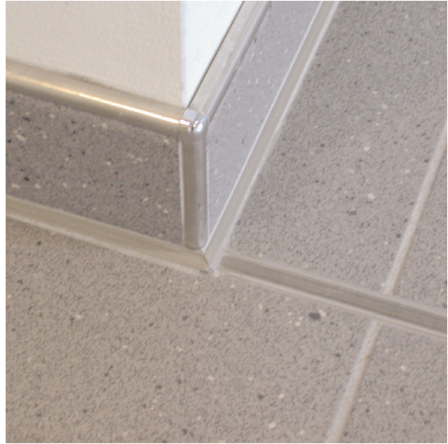
Figur 7.1.2: Seksjoneringsfuge ved trappehushjørne
