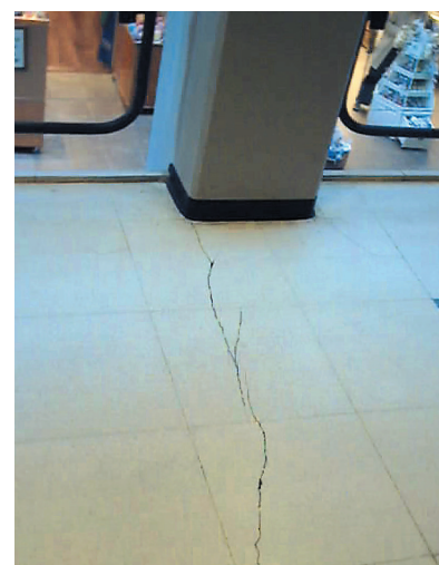
Figur 1.1 Oppsprekking av keramiske fliser i elementbygg.
