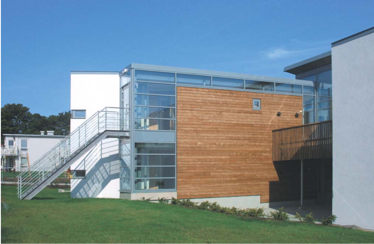
Korridorzone og rømningsstrapp mot vest
