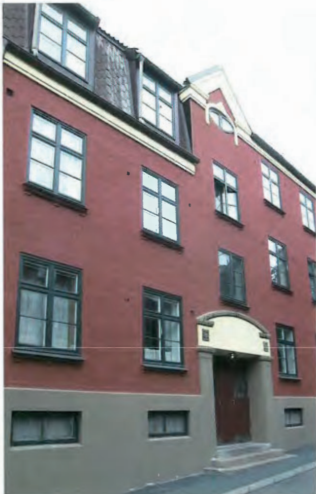
All gammel puss ble fjernet, deretter ble fasaden grunnet, slemmet og malt med silikatmaling
