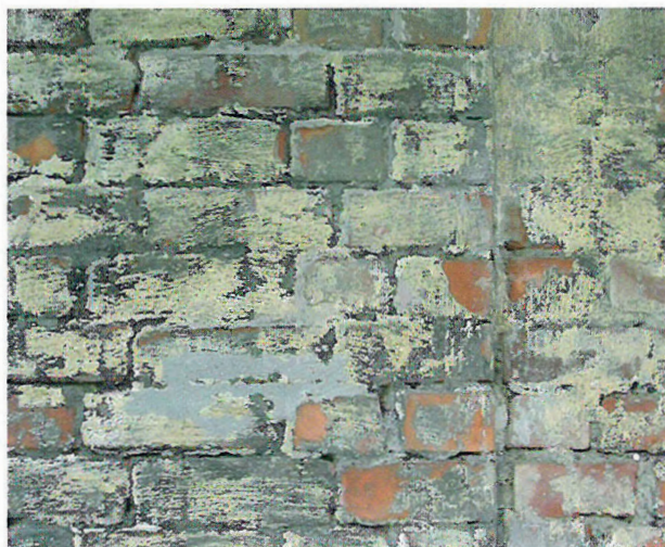
Vegg med sementbasert slemming og organisk maling etter behandling med kjemisk malingsfjerning
