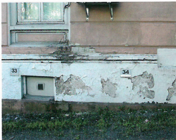
Mur med permanent oppstigende fukt og pusset med tradisjonelle mørtler vil med stor sannsynlighet bli skadet av frost og salter, både i puss og malingsjiktet.
